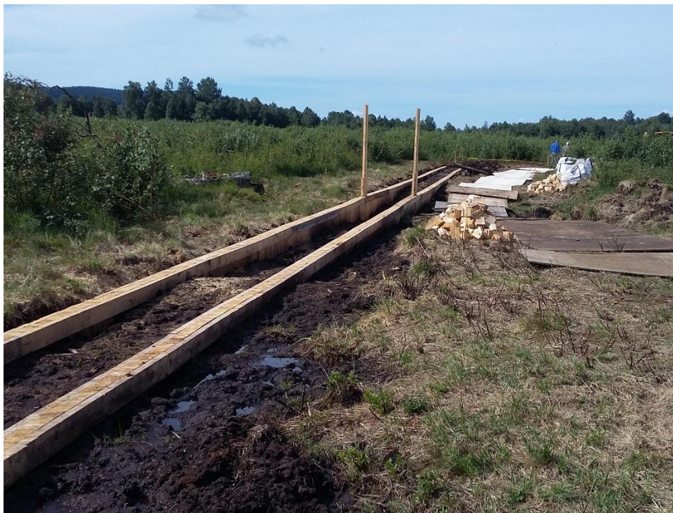
Double palissade submersible sur la Grande Seigne aux Granges-Narboz/Pontarlier/Houtaud (25)
