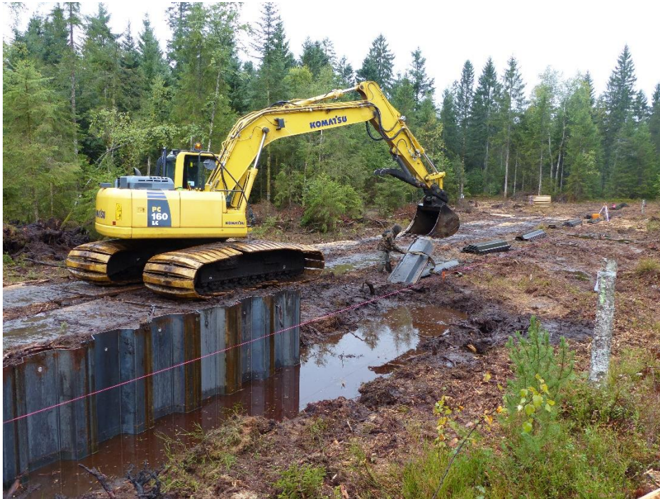
Palissade métallique sur la tourbière du Creux-au-Lard à Frasne (25)
