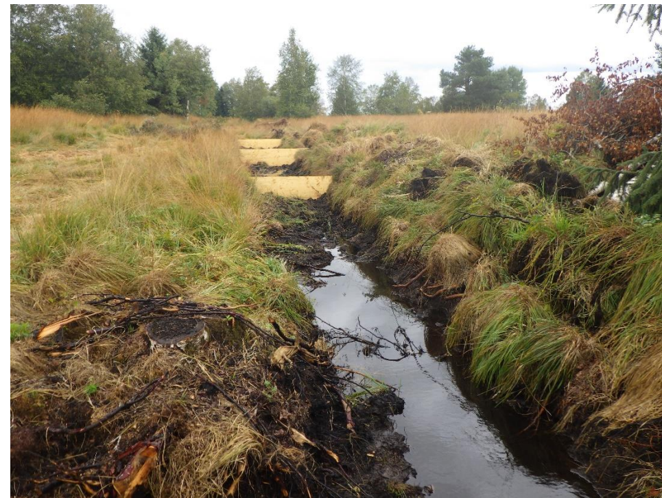
Neutralisation de fossés de drainage à la Corne du Marais à Bouverans (25)
