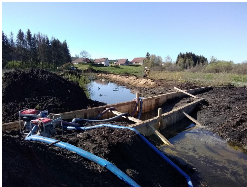
Double palissade et comblement de fossé sur la tourbière du lac à Malpas (25)
