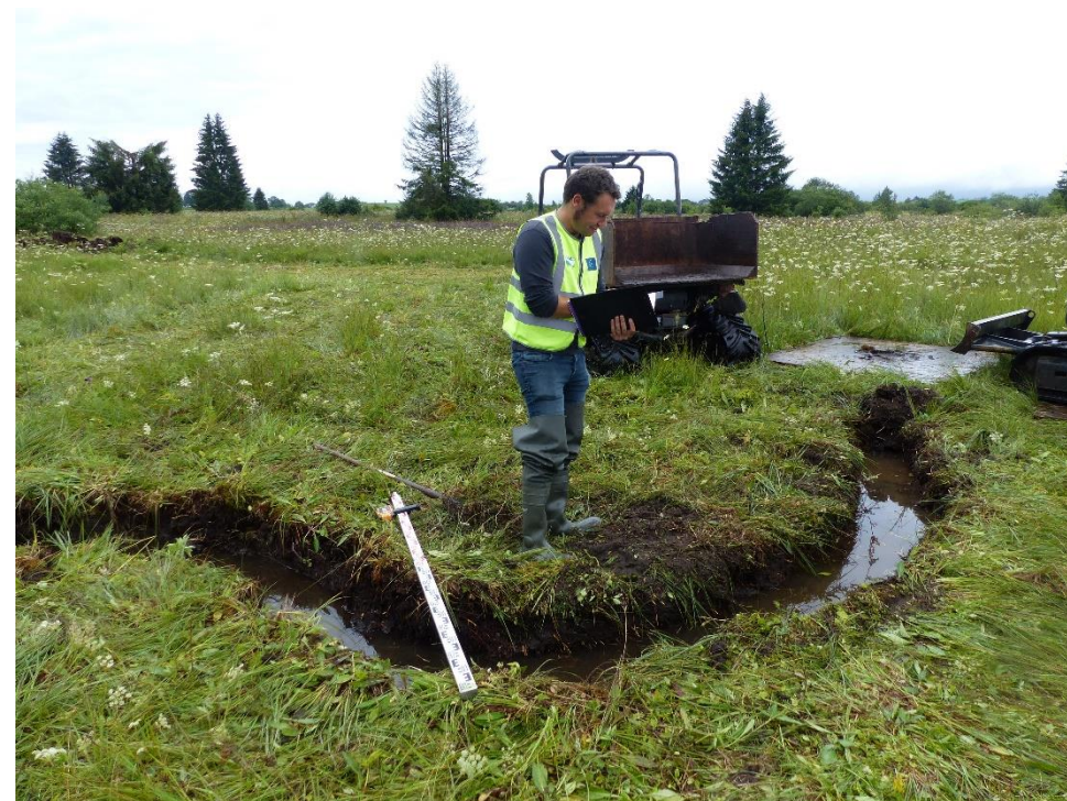
Creusement d'un nouveau lit pour le Gouterot à Bannans (25)
