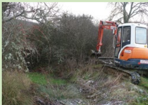
Restauration d'une mare à Beurizot
