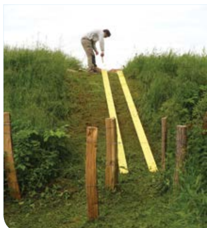
Réalisation d'un escalier d'accès à la digue du sentier de Longepierre (71) G. Aubert - CENB
