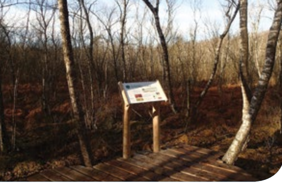
Installation de pilotis en périphérie de la tourbière de la Lioche et de deux panneaux d'interprétation à la Réserve Naturelle Nationale de La Truchère-Ratenelle (71) R. Vuillemin - CENB
