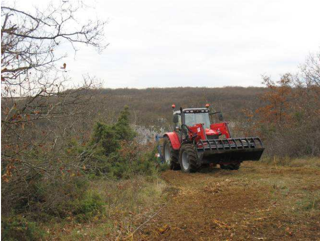
Photographie 1 : Travaux lourds de reconnexion de pelouses sur la commune de Chambolle-Musigny (Caux S., CENB-2010)
