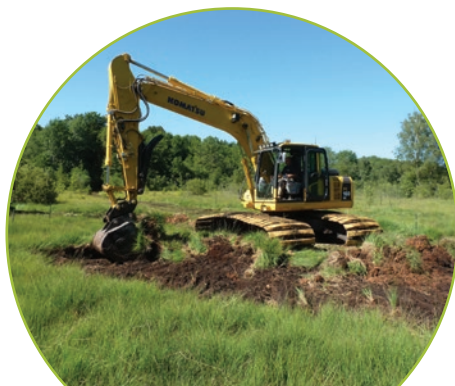
Travaux de réhabilitation d'une tourbière S. Moncorgé - CENFC
