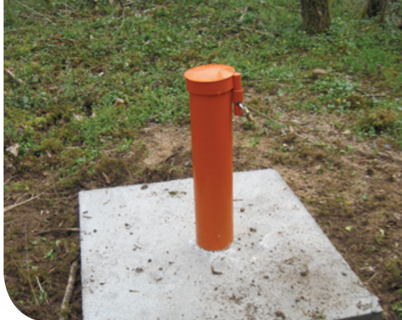
Tête de puits cimentée coiffée d'une dalle en béton © B. Fritsch (CEN Bourgogne)
