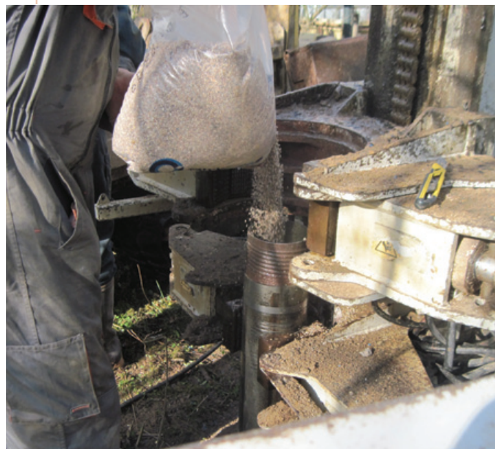
Le forage fait, c'est la descente du tube crépiné, puis du remplissage de l'espace par un massif filtrant de type sable 2/4. © B. Fritsch (CEN Bourgogne)
