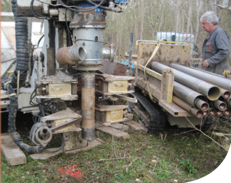
Le forage consiste à descendre successivement des portions de tubes et de forets métalliques et d'extraire en même temps les matériaux du sous-sol © B. Fritsch (CEN Bourgogne)
