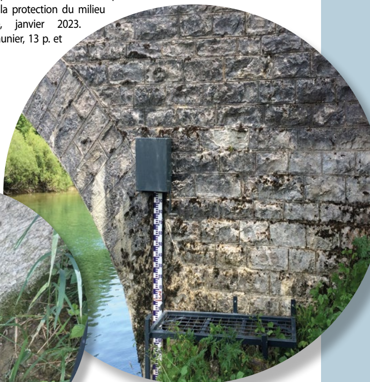
Dispositif de mesure et de télétransmission de données © FJPPMA
